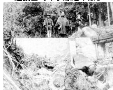
建設当時の水源池の様子
