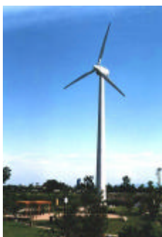
風力発電機の例
