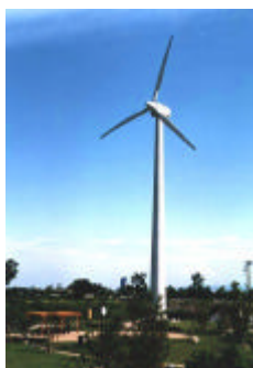
風力発電機の例
