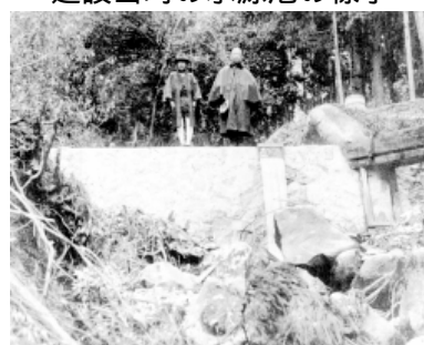
建設当時の水源池の様子
