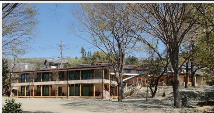
2021年3月新園舎完成
