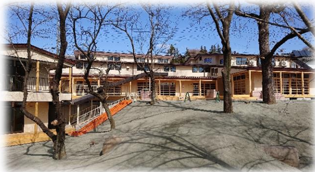
2021年3月新園舎完成
