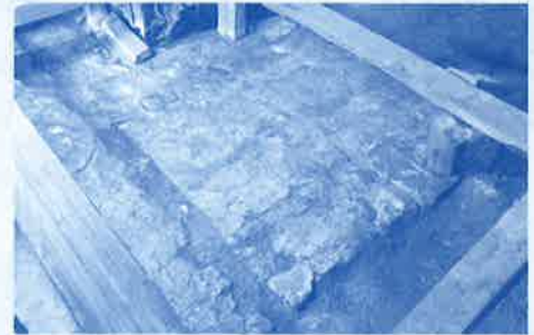
煉瓦床の痕跡(煉瓦下地の砂漆喰)
