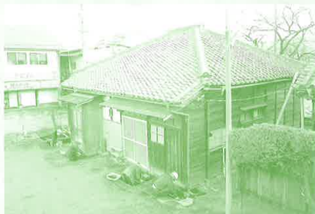
建物周囲の調査
