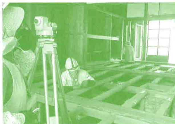
建物内部の調査
