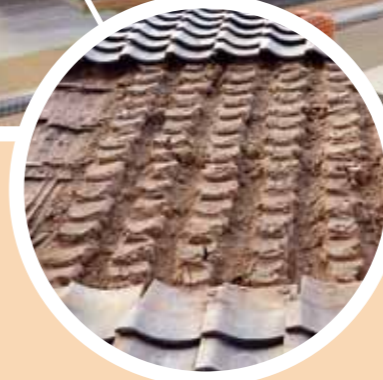
▲ 一部屋根瓦を取り外した様子
