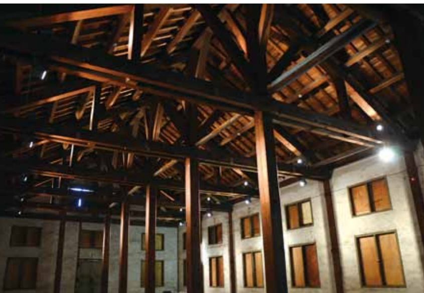
照明に照らされ、独特の雰囲気を出すトラス構造の小屋根
