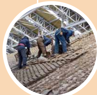
▲ 解体作業の様子
