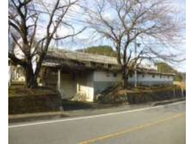
養蚕所への改修の事例 (妙義町菅原地区)
