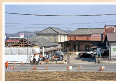
▲新たな交流拠点として利活用するため、整備工事を進めている富岡倉庫 (3月15日撮影)
