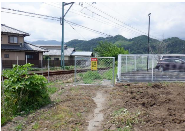
田島西踏切（富岡市田島 266-2）
